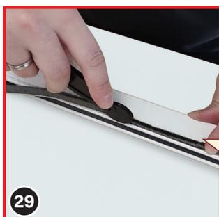
Insérez maintenant le joint à brosse dans les rainures des rails de guidage et du profil de finition à l'aide de l'outil de pression (16). La position des brosses est déterminée par la manière dont le store s'ajuste à la pente de votre fenêtre de toit, par exemple en reposant sur un rebord de fenêtre. Coupez les brosses excédentaires avec des ciseaux.
