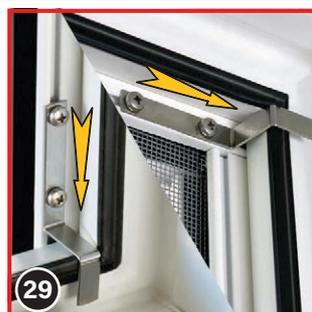
Positionnez ensuite les équerres sur le caisson du store et les rails de guidage de manière à ce qu'elles s'accrochent au cadre de la fenêtre. Serrez ensuite fermement les vis.
