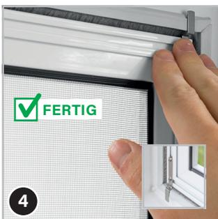
Beim positionierten Fliegengitter nun noch die Ecken ein wenig mit den Fingerspitzen andrücken, damit das Fliegengitter wirklich ganz genau sitzt.
