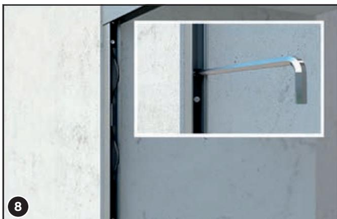
Tendez maintenant les cordons avec les blocs de réglage noirs à l'intérieur du rail de fixation (5).
