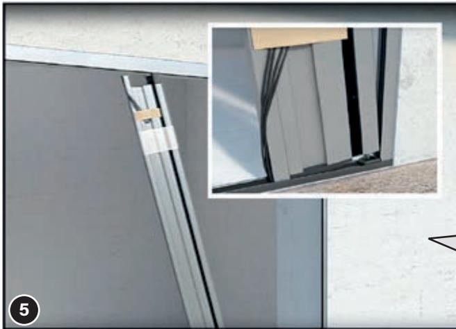
Fixez maintenant le coffre plissé dans l'aimant du rail de fixation (5). Placez simplement le coffre plissé entre le rail de guidage (1) et le rail inférieur (2). L'aimant situé à l'arrière du coffre plissé s'enclenchera dans l'aimant du profil mural.
