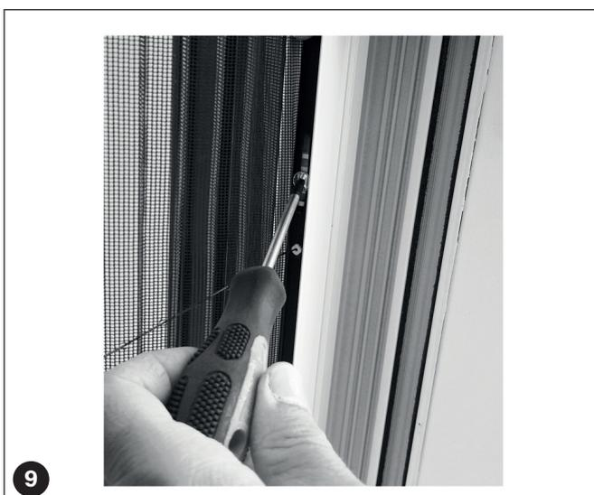
Bei Bedarf die Einstellung der einzelnen Schnüre direkt auf der Kante des Kastenprofils (5a) vornehmen.
