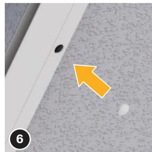
Insérez les capuchons de recouvrement (15) des trous sur les trous percés.
