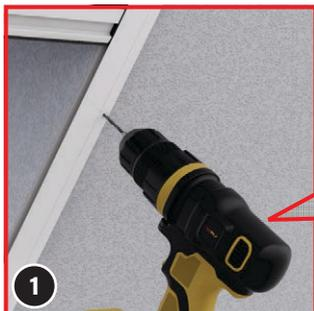
Percez 2 à 3 trous dans les profilés latéraux du cadre de montage (6) avec un foret de  $\varnothing$  4 mm. Les distances correctes sont indiquées sur l'image ci-contre.
