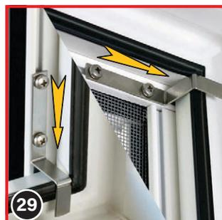
Positionieren Sie nun die Winkelaschen am Rollokasten und den Führungsschienen so, dass diese über den Fensterfalz greifen. Ziehen Sie anschließend die Schrauben fest.
