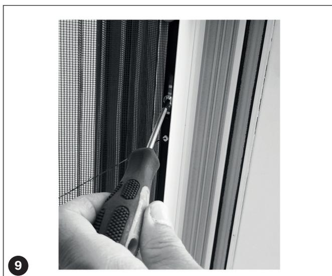
Si nécessaire, effectuez le réglage des cordons individuellement directement sur le bord du profil de caisson (5a).
