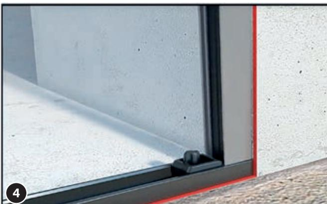
Percez préalablement le rail de fixation (5). Faites d'abord 2-3 trous avec un foret de petite taille (par ex. Ø 4 mm) à travers l'aimant et le profil.
