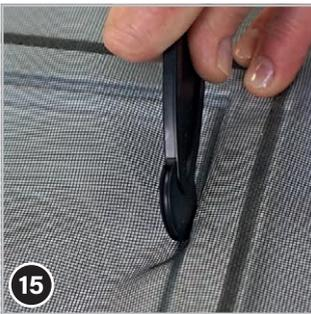
Zuerst Fliegengitter 10 mit Kedereindrücker 5 **ohne Gummikeder 9** in Nut der Schiebetür vordrücken. Das erleichtert das Einziehen mit Netz.
