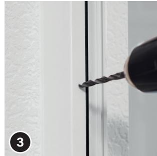
Retirez le cadre. Percez un trou de  $\varnothing$  4,5 mm à chaque position marquée si vous ne souhaitez pas utiliser de douilles pour goupilles. **ATTENTION** Pour les fenêtres en bois, l'utilisation des douilles est fortement recommandée. Dans ce cas, percez les trous avec un foret de  $\varnothing$  6,5 mm.
